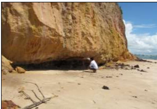
FIGURA 04: Erosão do pé da falésia do Cabo Branco Fonte: FADURPE.
