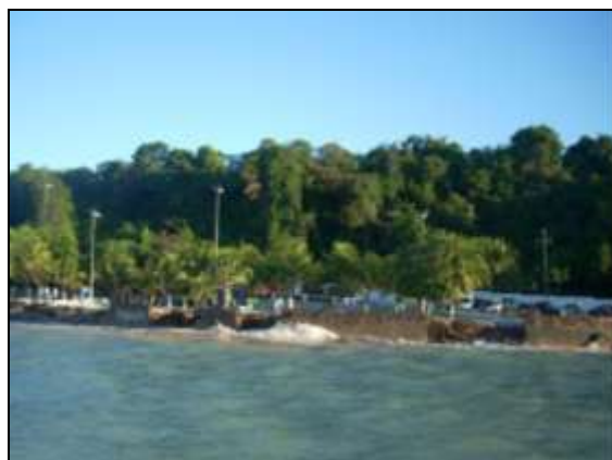
FIGURA 07: Dano decorrente da erosão nas áreas adjacentes a Praça de Iemanjá, comprometendo a própria praça, muro de arrimo, calçada, ciclovia e via de circulação de veículos. Fonte: SEMAM.
